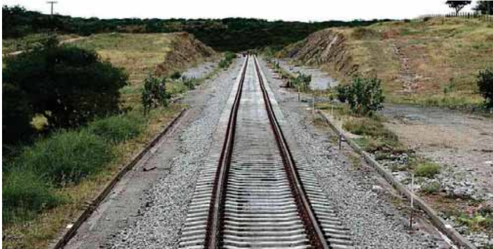
Obras da Ferrovia de Integração Oeste-Leste, de responsabilidade da estatal Valec, no município de Tanhaçu (BA)
