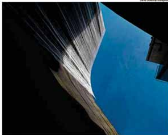
ILUSTRADA NOVA Em restauração, edifício Copan, no centro de São Paulo, ganha tela de cor branca; ela substitui a proteção azul, que sofre com vendavais e estava rasgada Cotidiano B4
