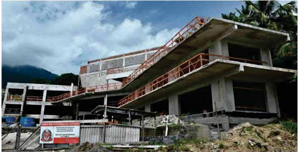
Prédio com obras paralisadas em Ilhabela, no litoral norte de São Paulo; local deve abrigar um centro de convenções e o primeiro teatro da cidade
